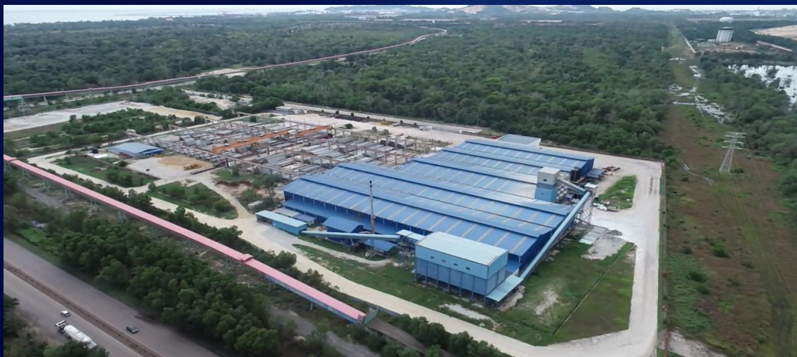
IPC管桩厂 IPC Piling
